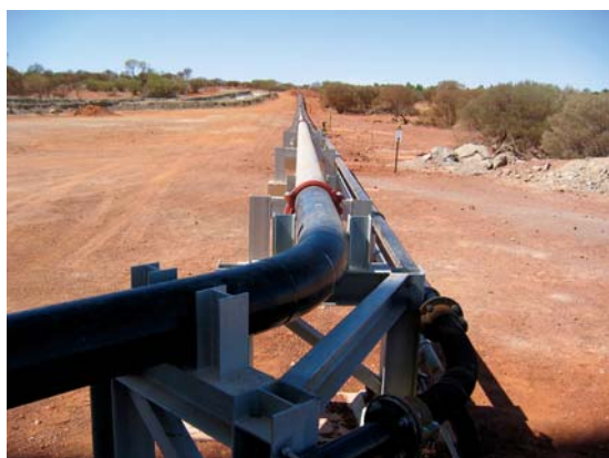
Рис. 5. Поршневые насосы могут перекачивать закладочный материал по трубопроводам на расстояние в несколько километров в зависимости от состава гидросмеси
