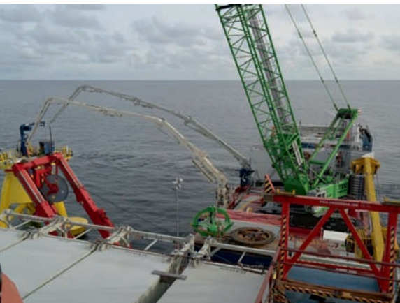
▲ Zwei MX 32-4 betonieren vom Schiff aus ein Fundament
