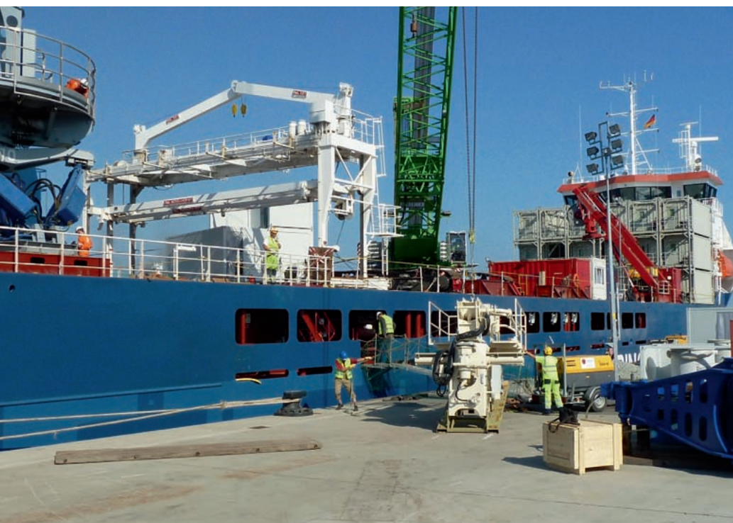
▼ Im Rostocker Hafen wurden die Armpakete der Stationärmaste auf das Schiff gehievt...
