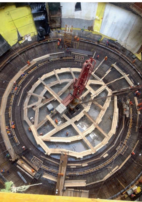
▲ Ein MX 32-4 Stationärmast in 110 m Tiefe
