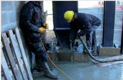
Заполнение стальных колонн
