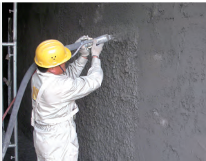
Внутренние штукатурные работы
