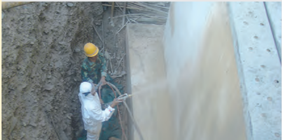
Покрывание бетонных фундаментов
