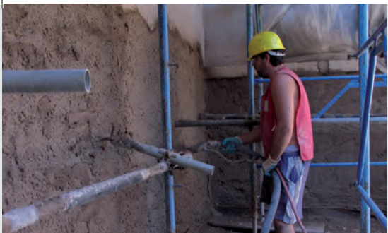
Наружные штукатурные работы
