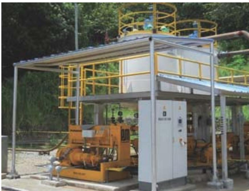
Участок перекачки нефти с песком с двумя насосами фирмы Putzmeister (Путцмайстер)
